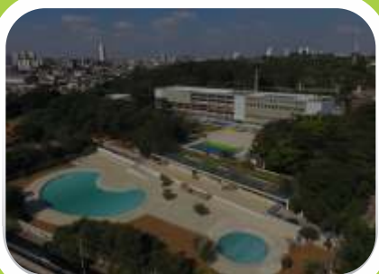
Construção do CEU na Vila Alpina
