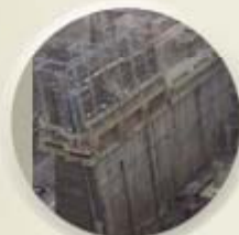
Casa de Força
